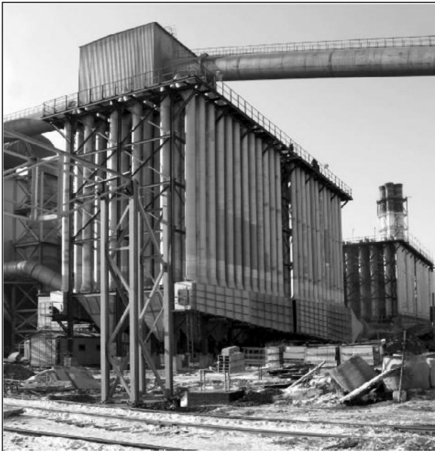
тирован по аналогии с охладителем комплекса печи ДСП-2. При работе печи ДСП-1 забор газов будет происходить также по газоходу
