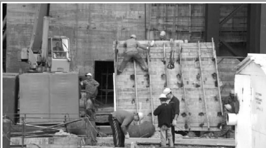
Фундамент основания машины непрерывного литья заготовок фирмы «SMS Demag». Здесь продолжается укладка бетона. Строители подрядных организаций выходят на отметку 12, то есть поднимают бетонное основание на высоту 12 метров от уровня пола пристроя МНЛЗ. Именно на этом бетонном основании в ближайшее время начнется монтаж современной слябовой машины фирмы «SMS Demag».
