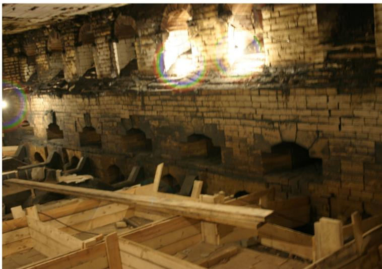
Стоит отметить, что осадительная камера расположена в таком месте, куда невозможно подвести кран, — говорит Ю. В. Тарасов, — поэтому многотонные металлоконструкции перемещаются и устанавливаются с помощью лебёдки и системы блоков. Такой труд требует большого опыта монтажных и сварочных работ. По окончании монтажа панелей другим подрядчиком — ООО «Свод» — будет производиться замена футеровки, из которой выложен пол и нижняя часть стен камеры.
